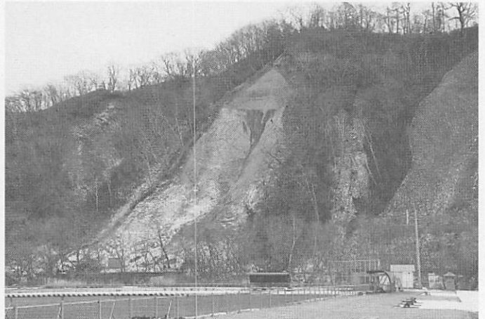
静内川河口、真歌地区の治山工事現場 (2014年12月17日)
